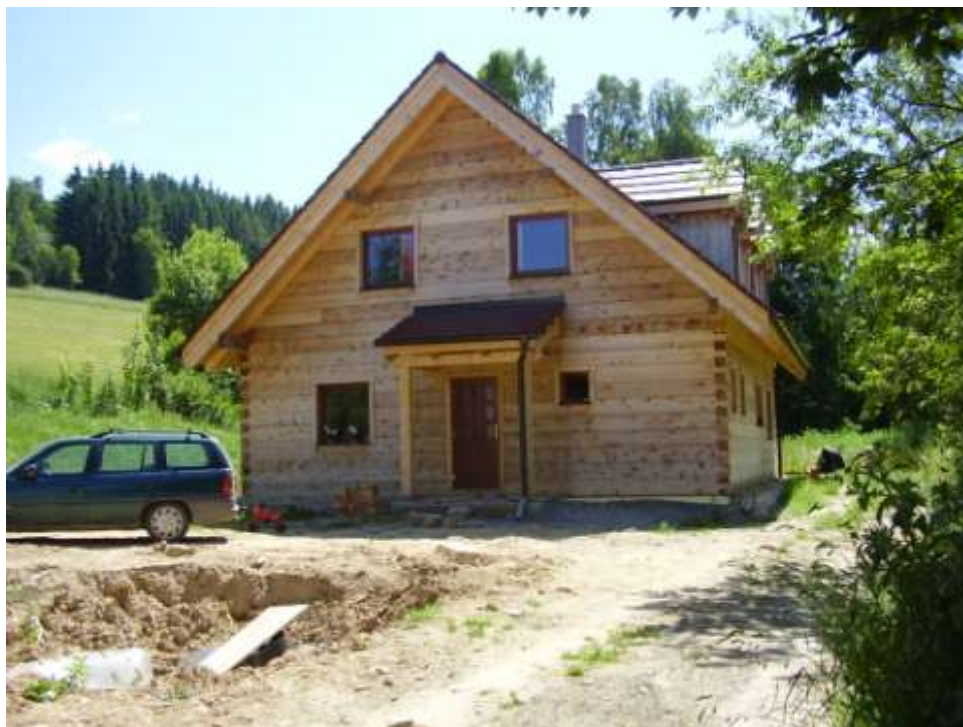
Nově postavený roubený domek ve stejné lokalitě v Ubušíně
