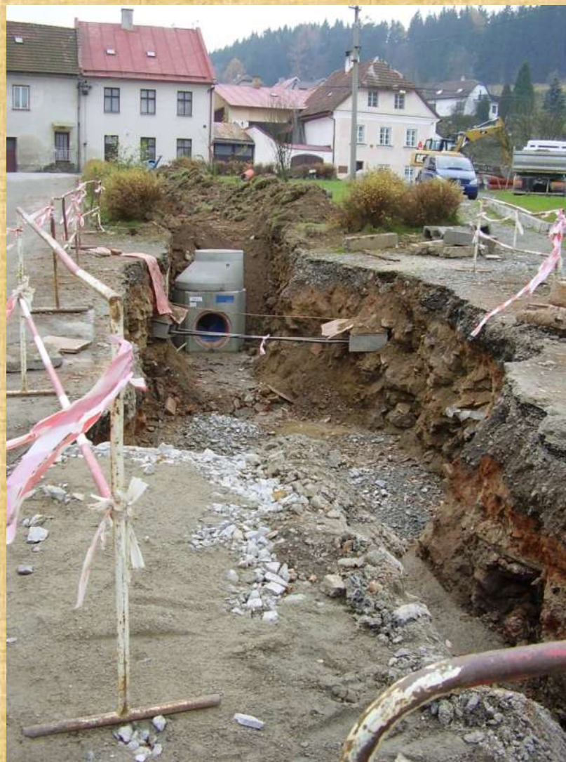
Kanalizace za zámkem
