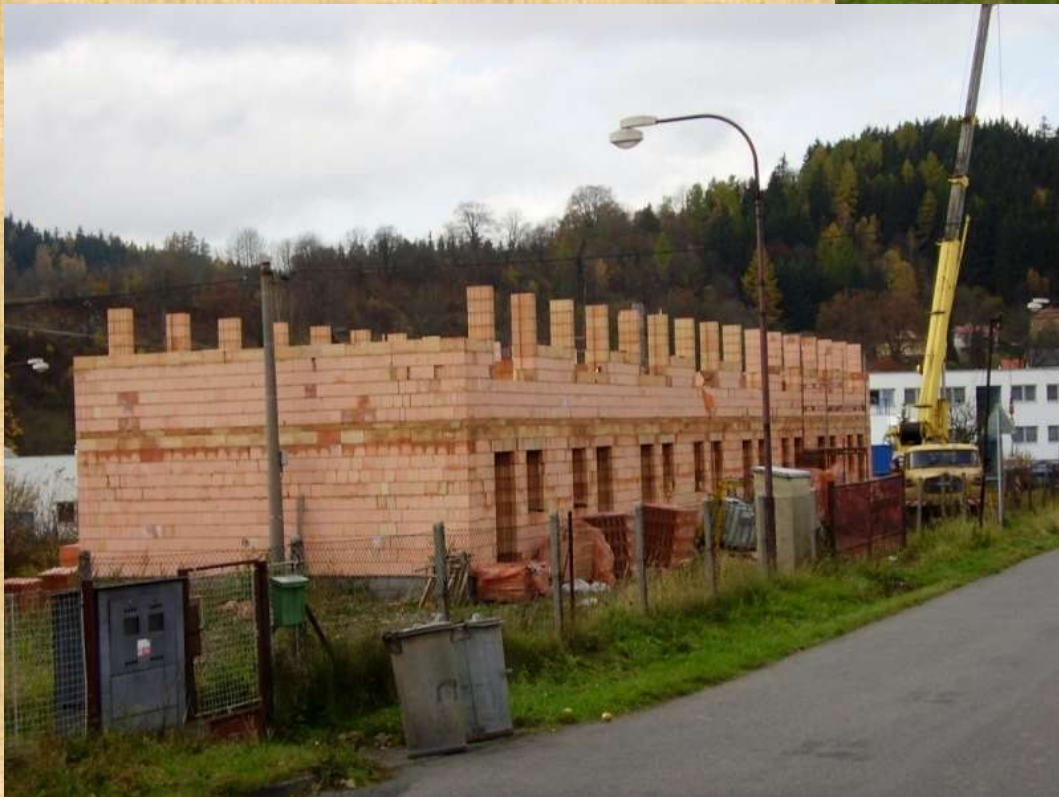
Výstavba osmibytového domu na Benátkách
