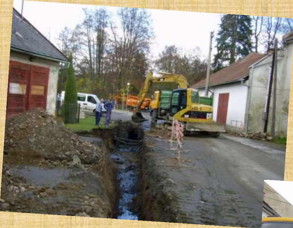
Kanalizace za zámkem
