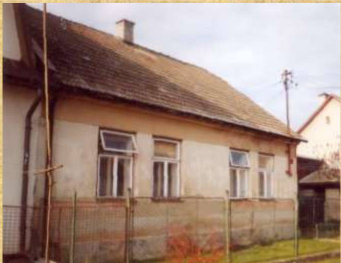
Dům před demolicí
