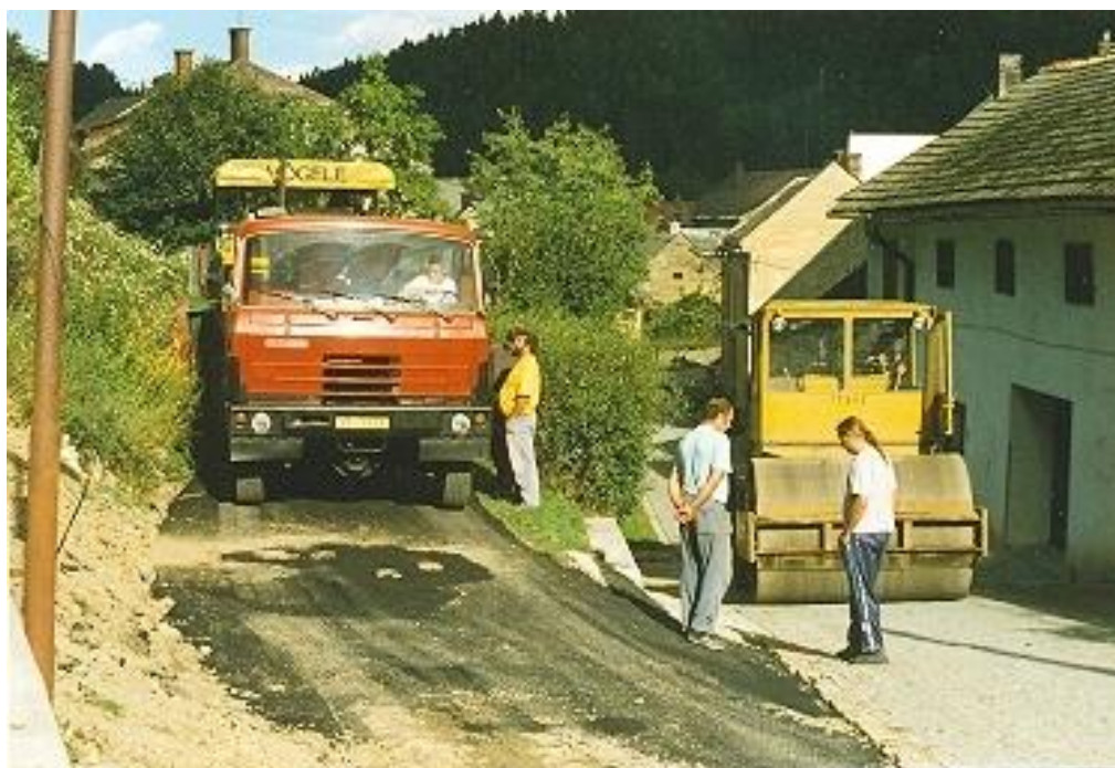
Oprava dlažby na náměstí
