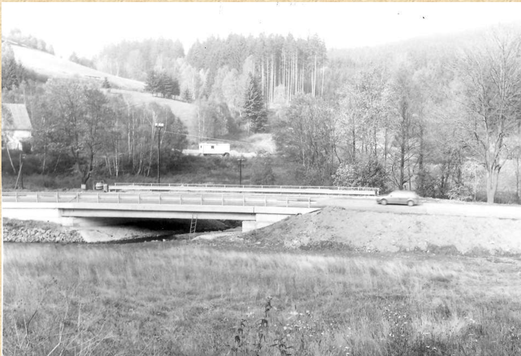
Začátkem listopadu 1996 byly dány do provozu nové mosty u N. Jimramova
