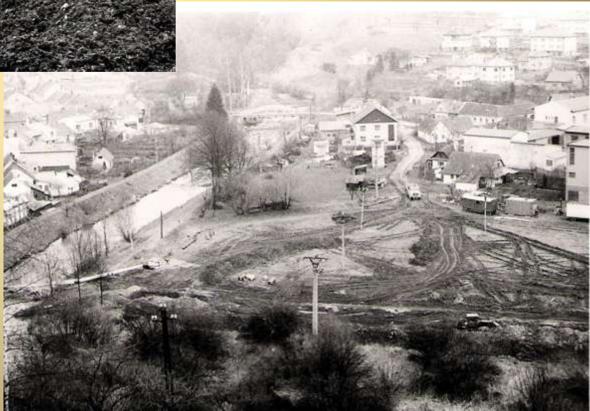
Stavba kanalizačního přivaděče k čističce odpadních vod
